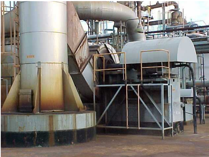
VISTA FRONTAL DO POSTO DE TRABALHO
